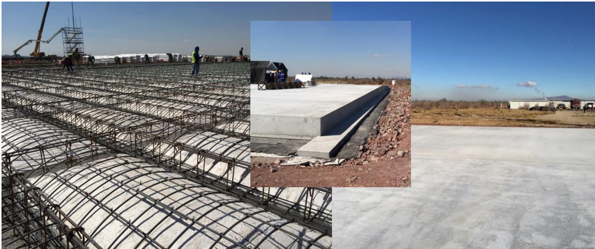
Nuevo Aeropuerto Internacional de la Ciudad de México Losas de pistas pos-tensadas de prueba
