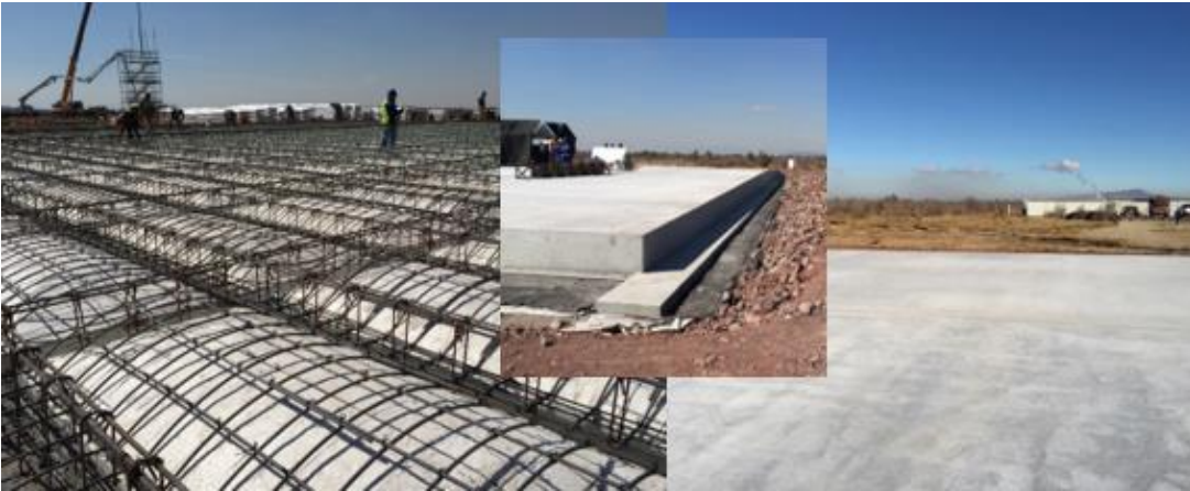
Nuevo Aeropuerto Internacional de La Ciudad de México
