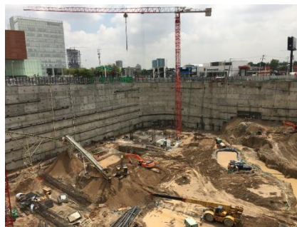
Proyecto Landmark, Guadalajara, Jalisco Losa de Sub-presión y muros con PENETRON ADMIX
