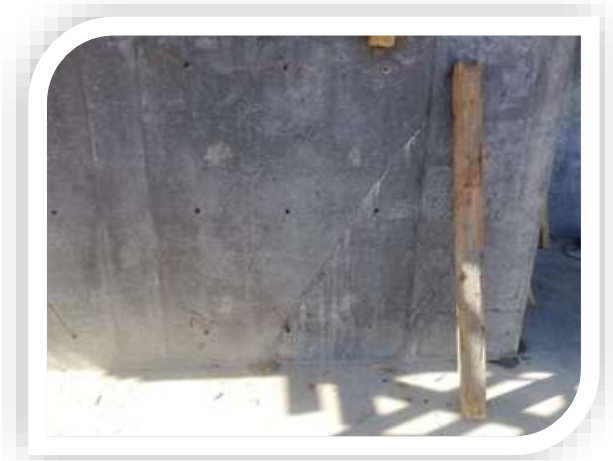
Capacidad de auto-sellado en una estructura de concreto tratada con PENETRON ADMIX
