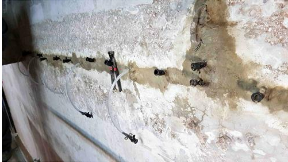
Puntos de inyección PENETRON INJECT
