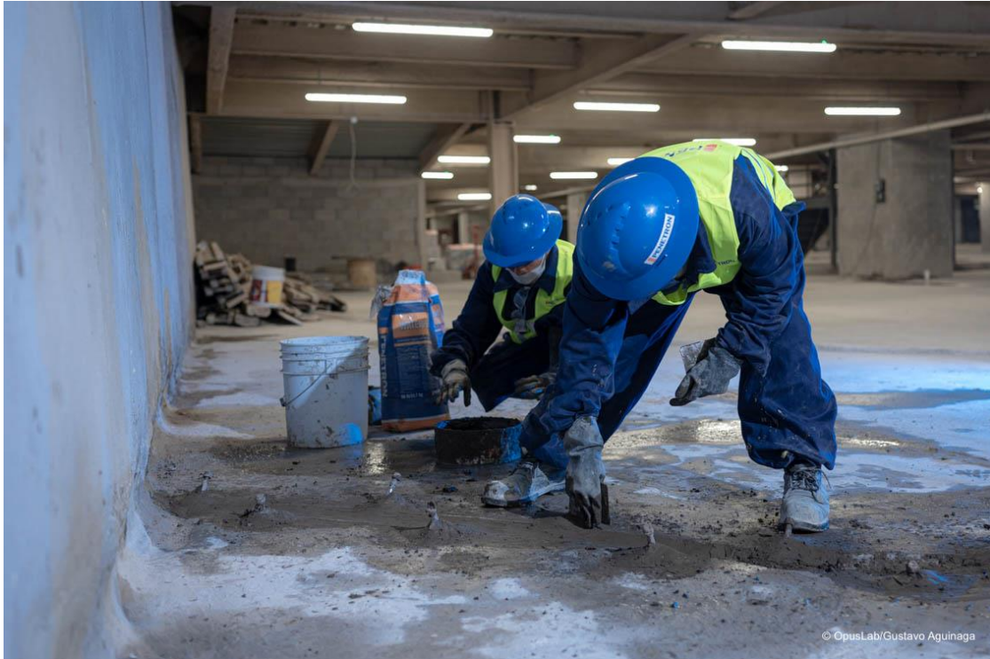
Puntos de inyección PENETRON INJECTION FOAM & RESIN
